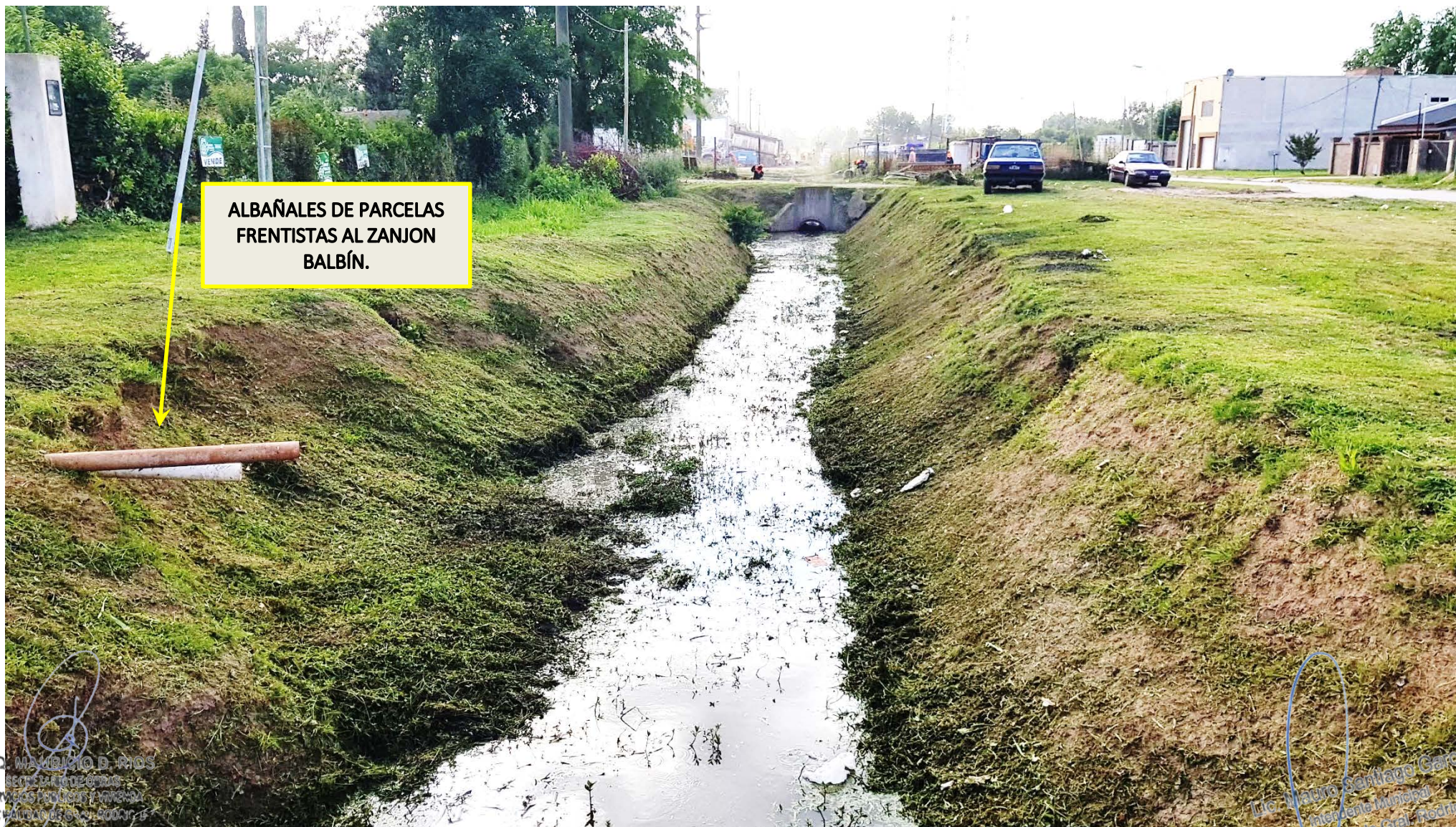
Foto 1: zanjón existente en Av. Balbín.
