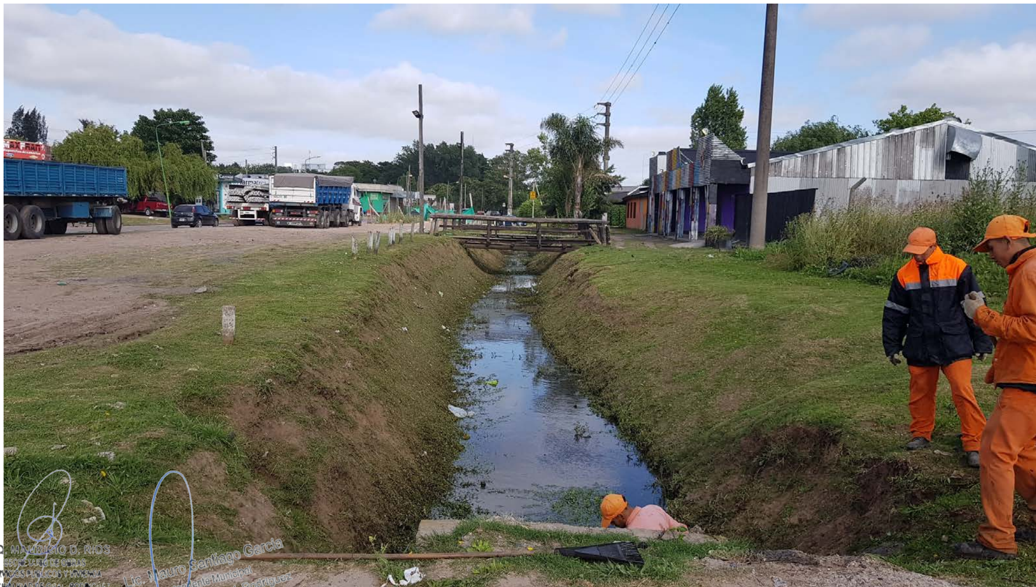
Foto 2: zanjón existente en la Av. Balbín.
